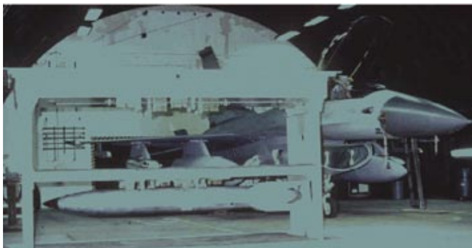
Bóveda Elevada de Almacenamiento de Armas (WSV) en un Hangar de Protección Aérea con un cuerpo B61. Fuente: Armas nucleares estadounidenses en Europa: Revisión de la política post Guerra Fría, niveles de fuerza y planificación bélica. Hans Kristensen, NRDC
